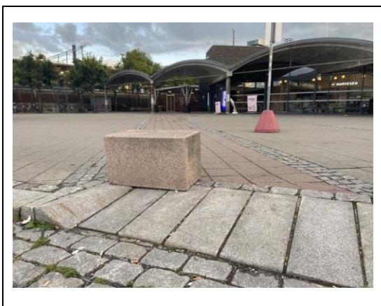
Bilde 2: Barriere rett foran stasjonen... (SLF LOO)
