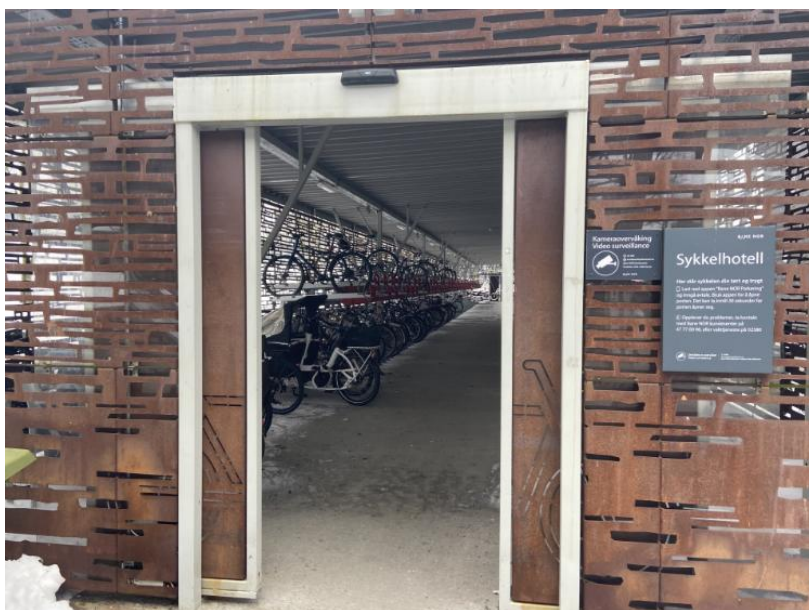
Bli med i diskusjonen om lokale sykkelforhold og sykkelparkering ved Lillestrøm stasjon!
